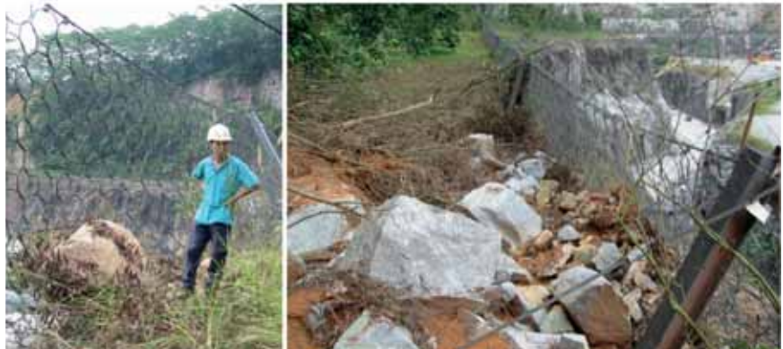
Fig. 4. Impacto puntual estándar e impacto múltiple que genera acumulación y carga estática. Mandai, Singapur.
