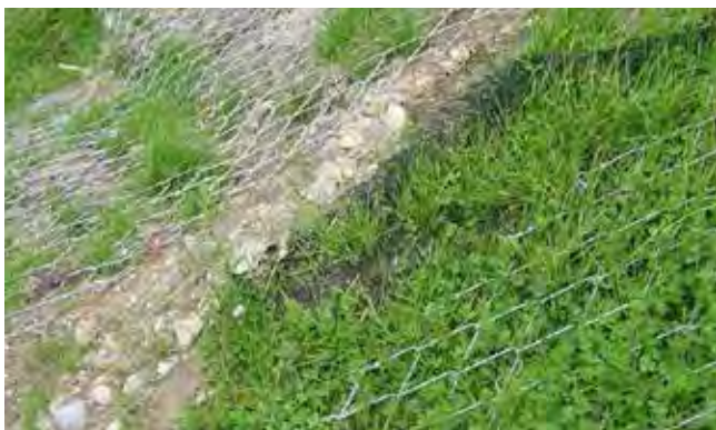
Abb. 6: Versuchsfläche ca. 10 Wochen nach der Nassansaat und nach einem Starkniederschlag. Links die Referenzfläche ohne Erosionsschutzmatte mit weniger als 10% Begrünungserfolg. Rechts mit einer Krallmatte mit einem Begrünungserfolg von mehr als 90%.
