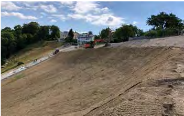
Abb. 12: Sanierte Böschung nach dem Aufbringen des Greenax® und dem Ausbringen von Saatgut.
