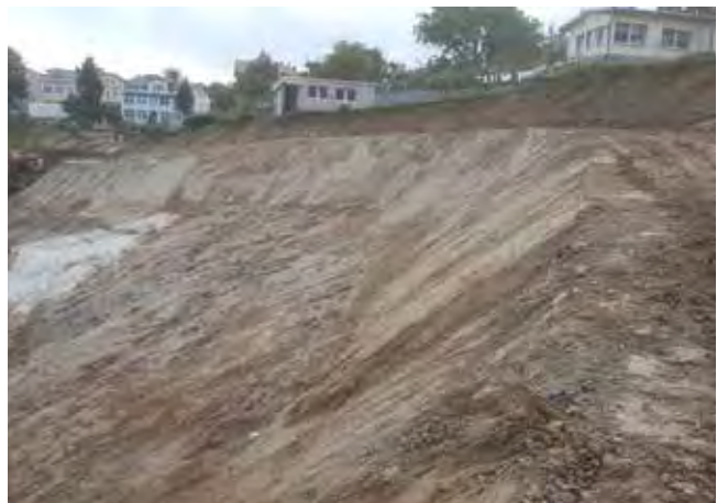
Abb. 10: Fertig gestellte Böschung mit dem Hydrozementationsverfahren.
