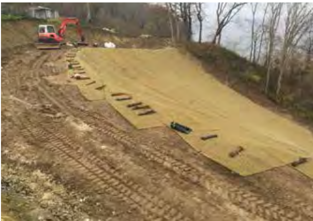
Abb. 11: Verlegen und Befestigung des Greenax® Geflechts.
