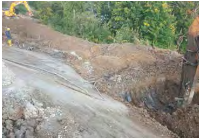
Abb. 9: Ausführung der Aushubarbeiten für das Hydrozementationsverfahren.
