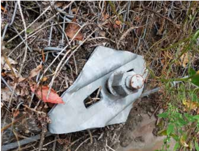
Abb. 10: TECCO® Geflecht, unteres Randseil, Krallplatte und Vernagelung (September 2017).
