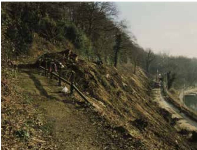
Abb. 6: Beräumung der Böschung und Abtrag instabiler Bereiche im Jahr 2000.
