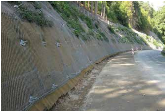
Abb. 1: Steilböschung mit einer Sicherung aus hochfestem Stahldrahtgeflecht - System TECCO®.
