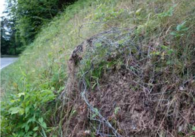
Abb. 17: Kleinräumiger Mähschaden im Bereich der Wiese.
