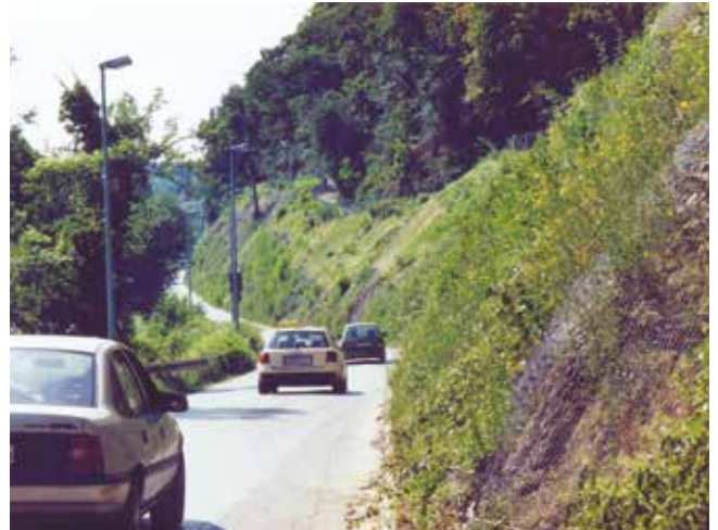
Abb. 7: Gesicherte Böschung im Jahr 2000 nach aktiver Begrünung mit einer Nassansaat.
