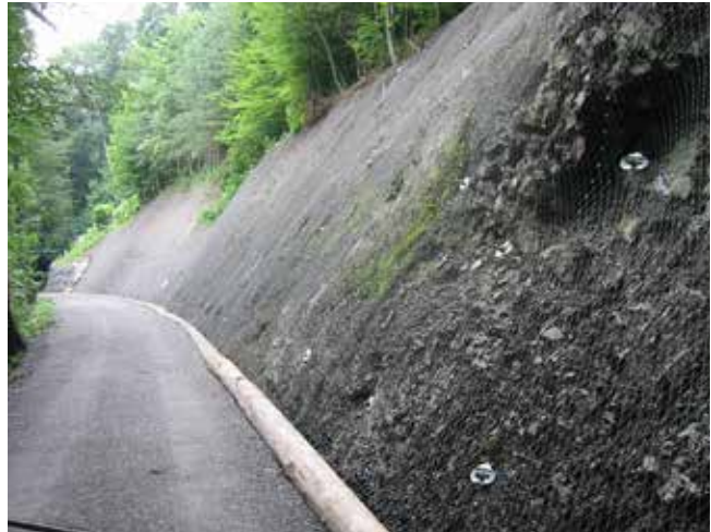
Abb. 11: Fertiggestellte Sicherungsmassnahme mit dem System TECCO® im August 2005.
