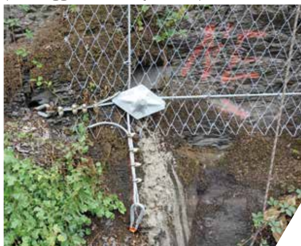
Consolidamenti di scarpate TECCO® (ancoraggio con fune di bordo)
