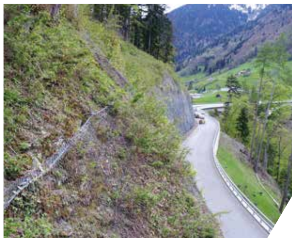
Sistemi di protezione da caduta massi (ancoraggio con fune portante)
