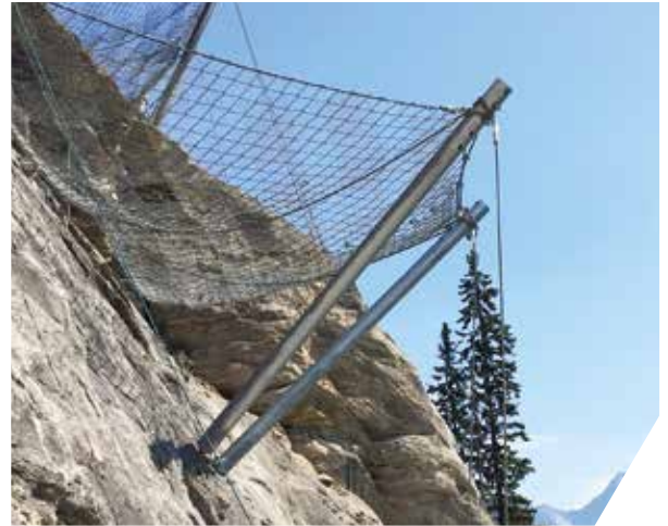
Prévention contre les avalanches avec des filets en câble spiröidal
