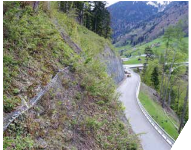
Steinschlag-Vorhänge (Tragseilverankerung)
