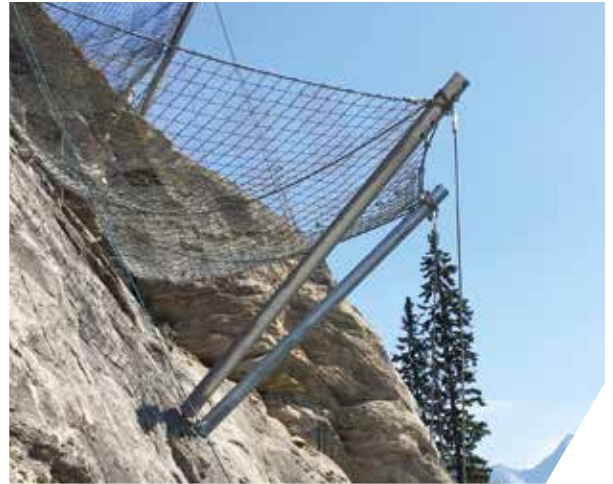
Lawinerverbauungen mit Spiralseilnetzen
