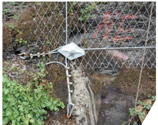
TECCO®-Böschungsstabilisierungen (Randseil-Verankerung)
