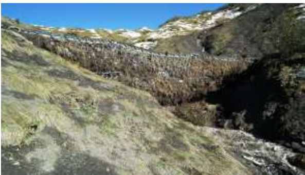
Abb. 9: Murgang-Barriere im Hasliberg / Schweiz mit erfolgreich gestopptem Murgang.
