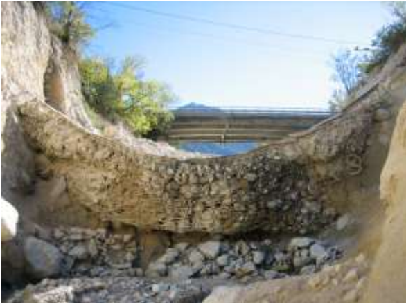
Abb. 1: Murgangstestverbauung im Illgraben 2006, Rückhaltevolumen ca. 1000 m 3 .
