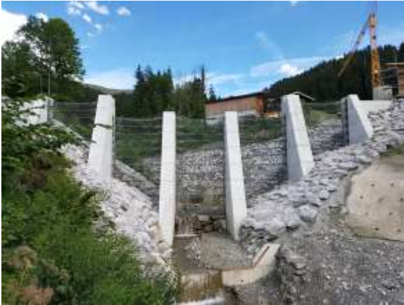
Abb. 10: Spezialbauwerk Murgangrueckhalt Sitebach Schweiz mit Betonscheiben.
