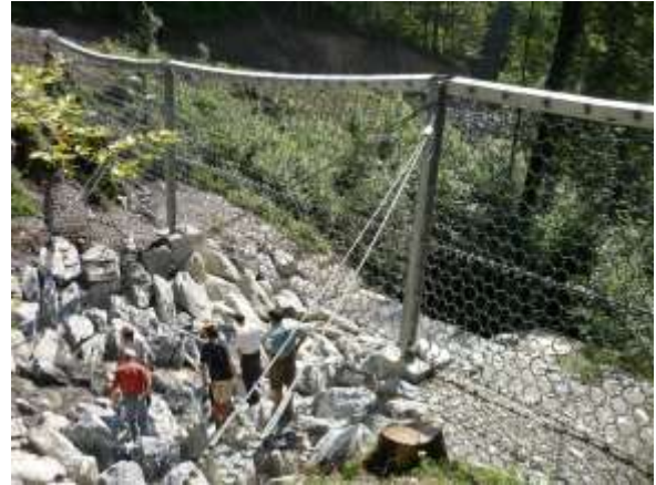
Abb. 2: Murgang-Barriere UX mit Stützen im Trachtbach (Schweiz) für breitere Bachquerschnitte. Zusätzlicher Kolkerschutz mit Blockwurf und Magerbeton an der Bachsohle.
