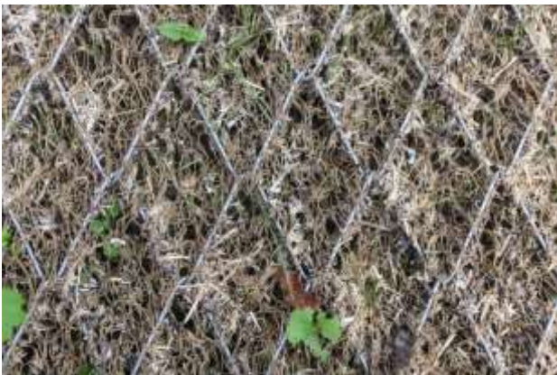
Abbildung 14: TECCO GREEN nach dem Aufbringen einer Hydrosaart.
