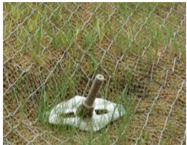
Abbildung 10: Erosionsschutzmatte TECMAT in Kombination mit dem hochfesten Stahldrahtgeflecht TECCO® G65/3 im Bereich der Bodenvernagelung.
