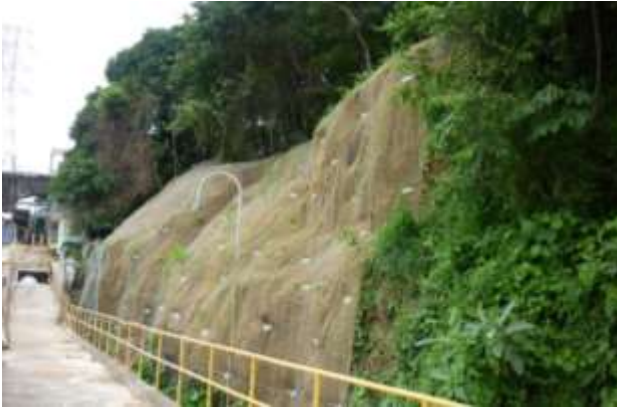
Abbildung 11: Gesicherte Felsböschung in Miraflores, Panama. Erosionsschutzmatte und Geflecht konnten gut an die unregelmässige Böschung angepasst werden.
