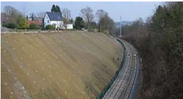
Abbildung 12: Sicherung einer Einschnittsböschung nach einer Rutschung im verwitterten Fels.
