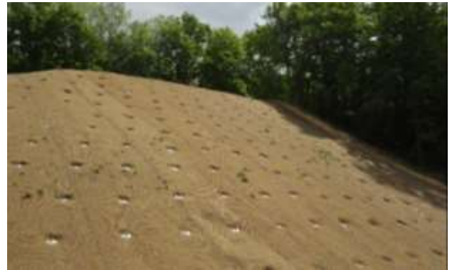
Abbildung 13: Gleichmässig profilierte Böschung im Lockergestein mit enganliegender Erosionsschutzmatte.
