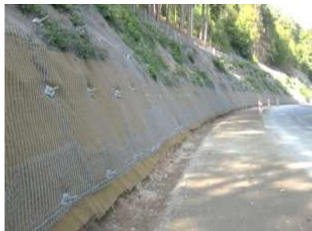
Abbildung 4: Böschungsstabilisierung mit hochfestem Drahtgeflecht und Erosionsschutzmatte (System TECCO® G65/3).
