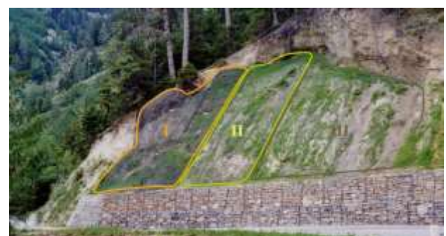
Abbildung 7: Versuchsflächen zur Evaluation einer Erosionsschutzmatte.
