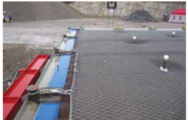
Bild 2: Versuch Nr. 5, TECCO® G65/3 + P33, bei Versuchsbeginn, sandiger Kies 0 - 63 mm, Nagelraster 2.5 x 2.5 m, Randbefestigung oben
