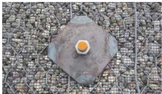
Bild 12: Test Nr. 7, Hexagonalstahldrahtgeflecht 80x100/2.7 mm mit Vertikalseilen in Abständen von 30 cm
