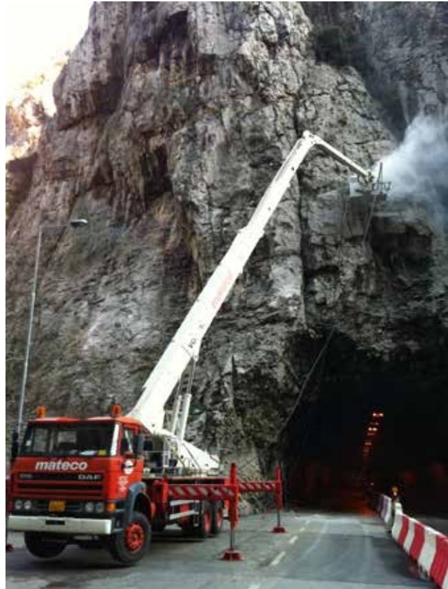
Bild 10: Bohrarbeiten an den bestehenden Tunnelportalen der M1
