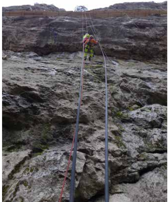
Bild 4: Celevecka Schlucht im Bereich der Tunnelportale
