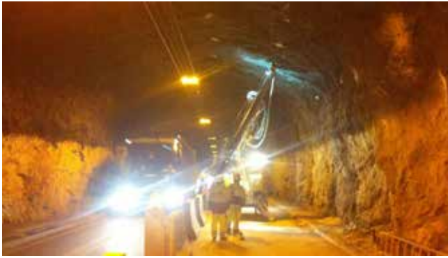
Bild 3: Bohrarbeiten im bestehenden Tunnel
