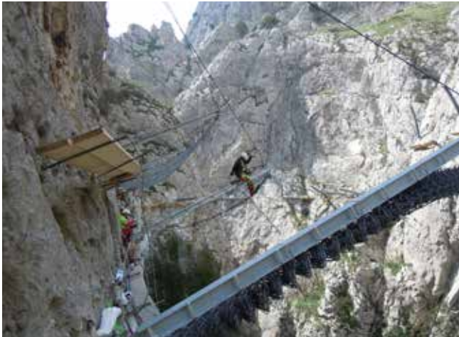
Bild 9: Installation der Steinschlagverbauungen in der Celevecka Schlucht
