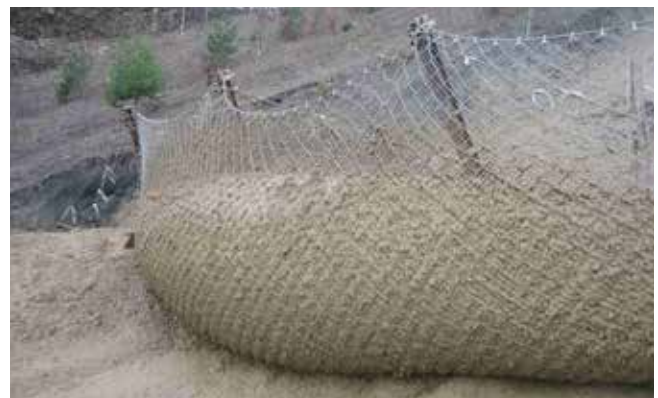
Abb. 8: Hangmurenbarriere nach der Belastung durch vier Wellen / Einschläge (Testanlage Veltheim, Schweiz). Der Entmischungsprozess Kies / Feinmaterial und die seitliche Ausbreitung sind gut zu erkennen.
