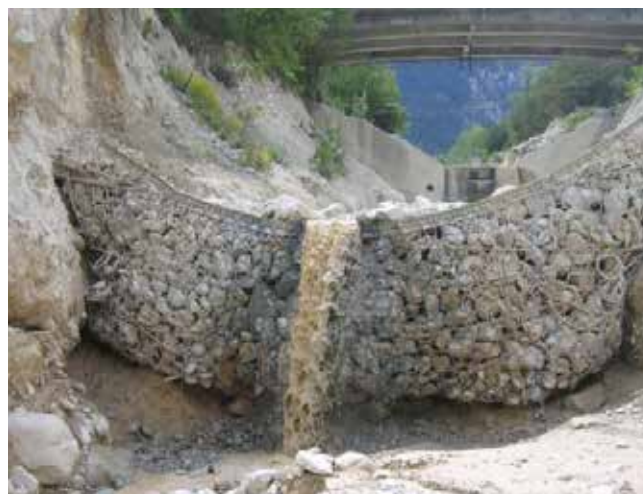
Abb. 4: Ringnetzbarriere in einem Gerinne. Testanlage Illgraben im Wallis, Schweiz
