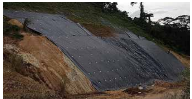
Abb. 16: Installation des TECCO STAINLESS System nach dem Rückbau der korrodierten Sicherungsmaßnahme.
