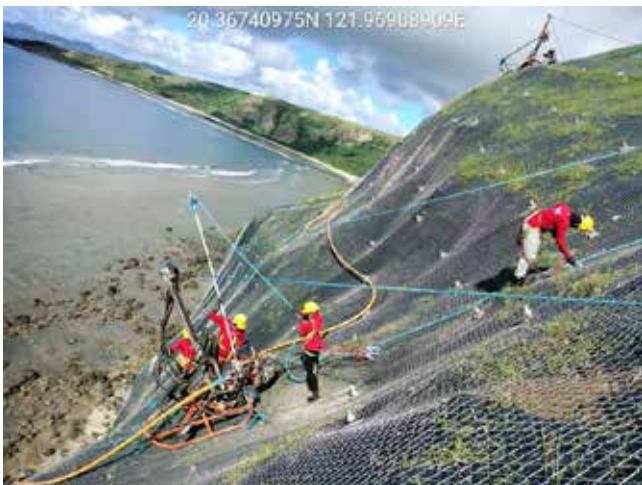
Abb. 6: Bohren durch das Geflecht mit einer Bohrlafette auf einen Schlitten montiert.
