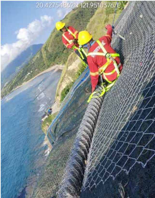
Abb. 5: Verlegen der Geflechte.
