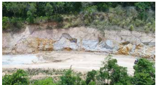
Abb. 8: Straßenböschung während der Baumaßnahme in den Ablagerungen von Aschen und Pyroklastischen Strömen. Entlang von Trennflächen bilden sich Rutschungen aus, weshalb die Böschung weiter nach hinten verlegt wird.
