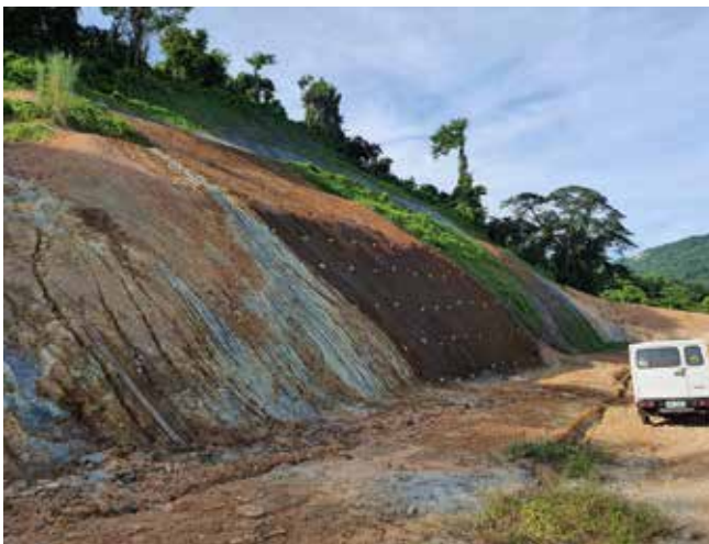
Abb. 10: Gesicherte Böschung mit dem TECCO Böschungsstabilisierungssystem. Die Rückverlegung am Böschungsfuß beträgt ca. 4 m. Im Bereich der Vegetation ist ein verstärkter Wasseraustritt, was zu Rutschungen geführt hat. Diese wurde durch die Sicherung gestoppt.
