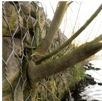
Bild 2 : überwallte Gabione
