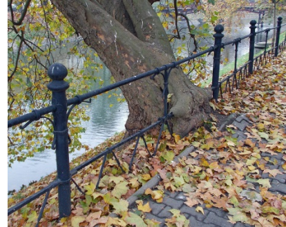
Bild 3 : Überwallung an einem Geländer
