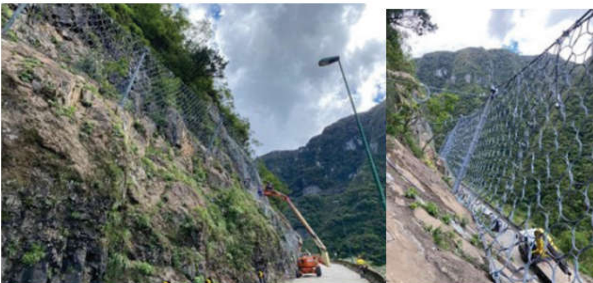
Figura 10: vistas da barreira do ponto 14 durante a fase de obras.
