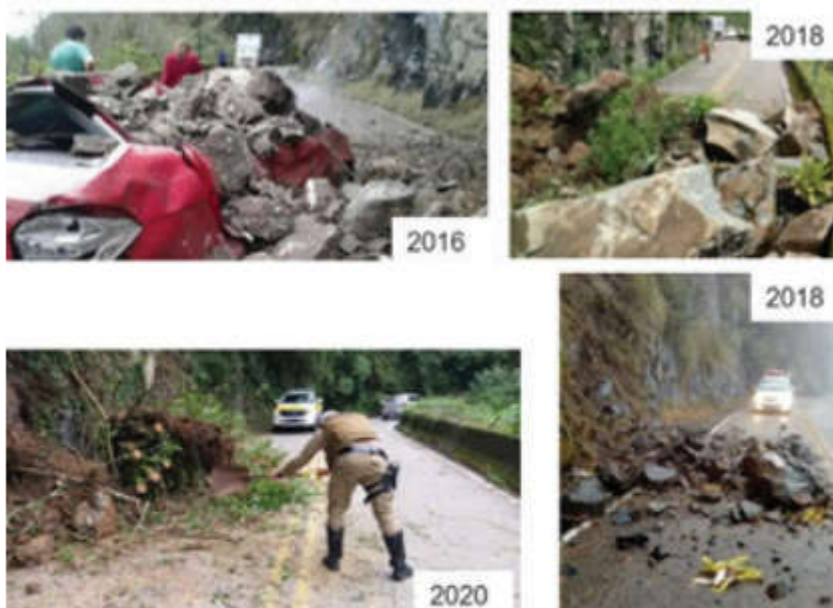
Figura 5: casos de acidentes geotécnicos na Serra do Rio do Rastro. (ref. sites de notícia e polícia rodoviária do estado de SC).
