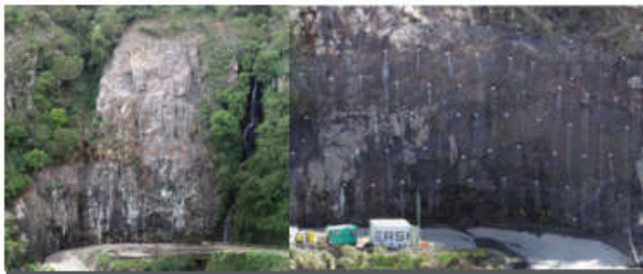
Figura 7: exemplo de tratamento com estabilização de talude rochoso com (esq.) sistema TECCO no ponto 1 e (dir.) sistema SPIDER e TECCO no ponto 3.
