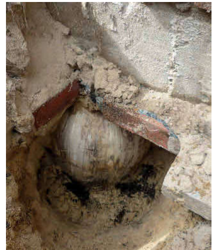
des Geotextilplatte zu erkennen. Foto: Uretek
