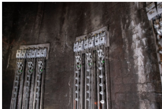
Fot. 3. Sztuczne dno szybu – widok od dołu
