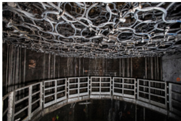
▶ Fot. 4. Widok sztucznego dna szybu oraz pomostu do kontroli
