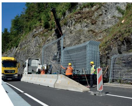
Configurazione rapida del sistema in combinazione con elevato assorbimento di energia.
