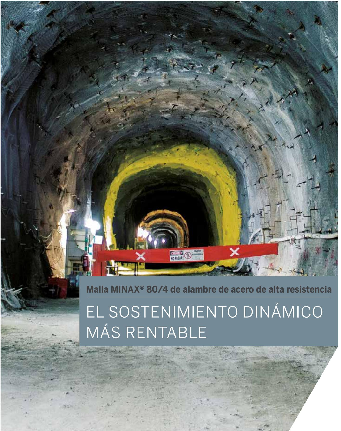
Malla MINAX® 80/4 de alambre de acero de alta resistencia
