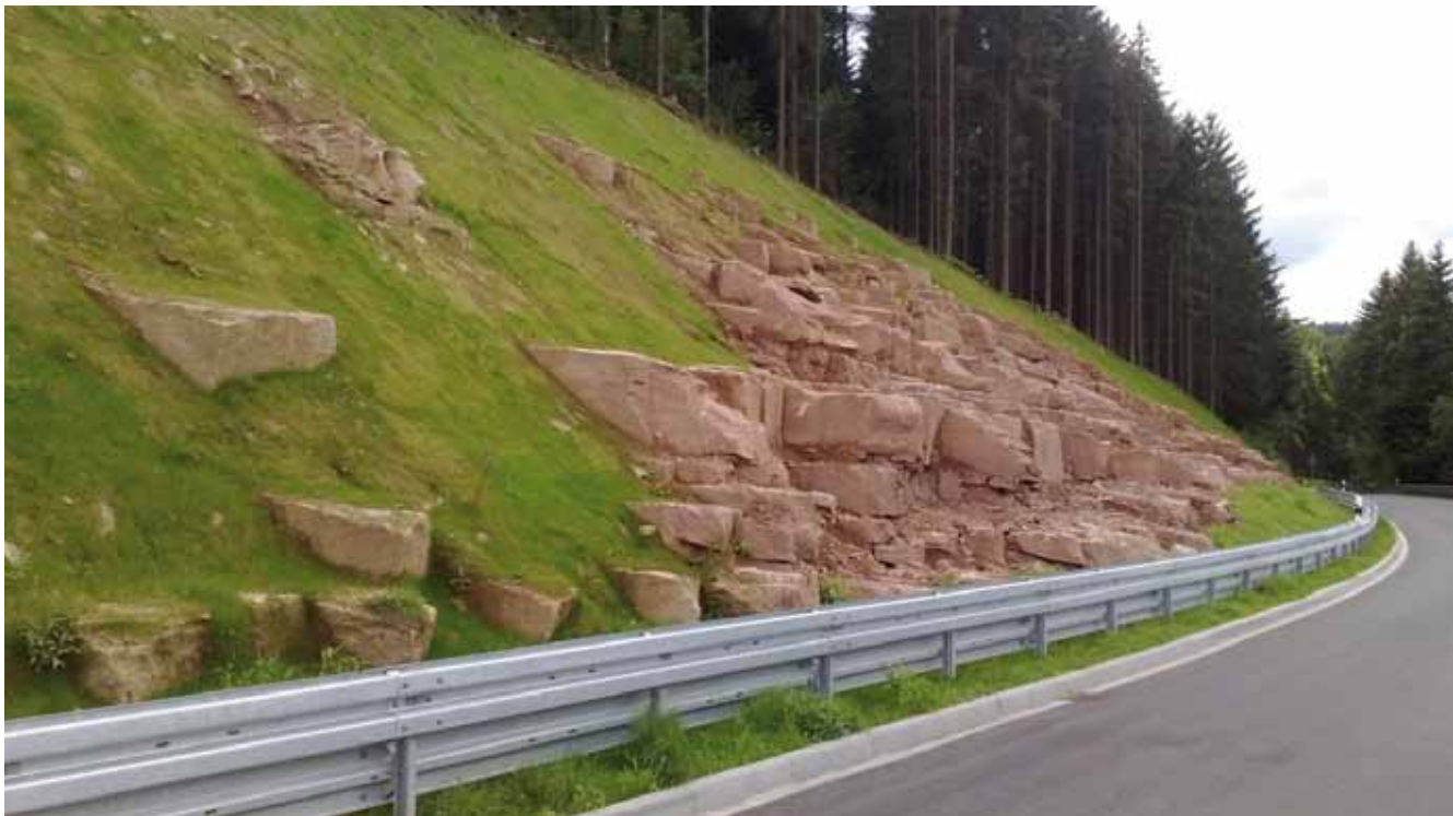
Abbildung 4: minimierte Steinschlaggefährdung durch abgeflachte Böschung
