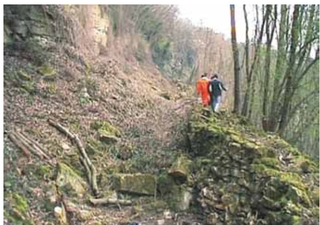
Abb. 1a: Reste der Fangmauer und bergseitig verfüllter Auffanggraben oberhalb der Bahnstrecke.
