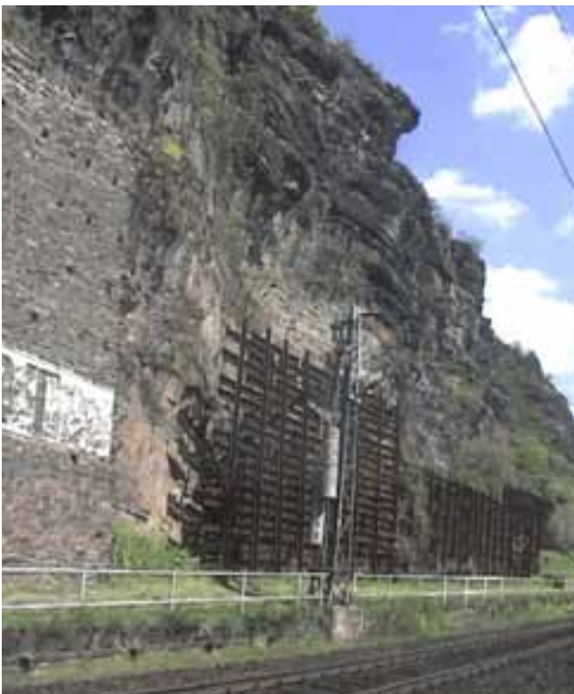
Abb. 4: Bis 7 m hohe Fangvorrichtungen aus Alteisenbahnschienen und -schwellen sowie ein Teil der Futtermauer.
