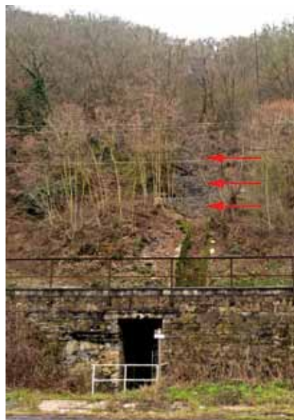
Abb. 2: Geländesituation nach Beräumung und Durchführung von Sicherungsmaßnahmen. Die Pfeile zeigen die Position der untersten drei Fangzäune, die im Auftrag der DB zur Sicherung hergestellt wurden (Foto: Wehinger 21.03.2013).
