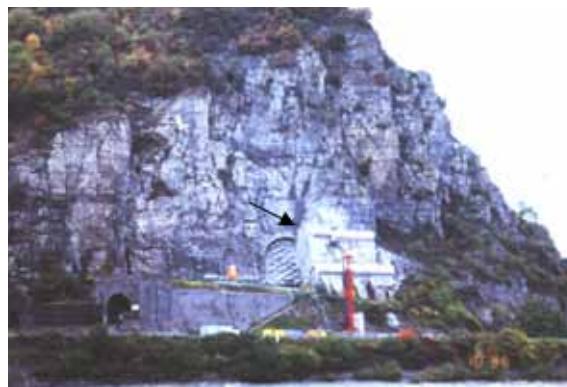
Abb. 3: Tunnelmund und der mit vorgespannten Bogenmauer unterfangene Felspartie.
