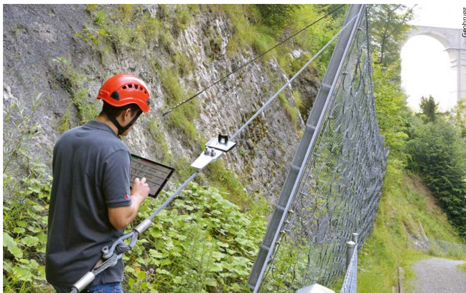
Installation eines Geobrigg Guard. Das Gerät ist einfach zu montieren und wird durch das Scannen eines QR-Codes per App in Betrieb genommen.
