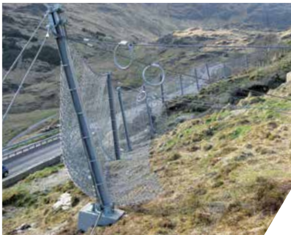
Protection contre les glissements de terrain superficiels (ancrage du câble porteur)
