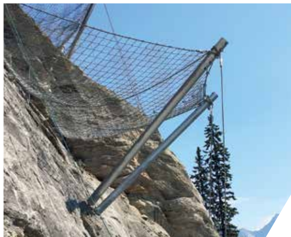
Prévention contre les avalanches avec des filets en câble spiröidal
