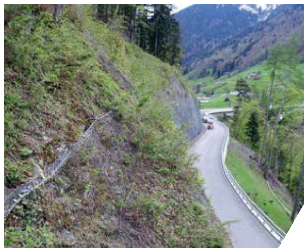
Cortina contra el desprendimiento de rocas (anclaje de cables de soporte)
