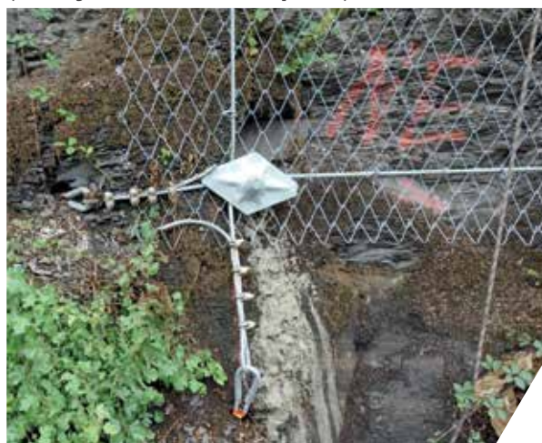
Sistemas de estabilización de taludes TECCO® (anclaje de cables perimetrales)
