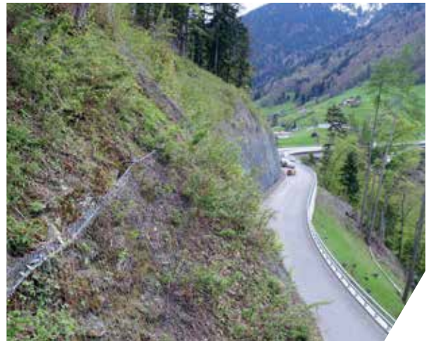
Steinschlag-Vorhänge (Tragseilverankerung)
