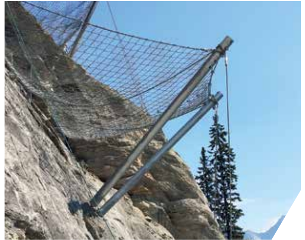
Lawinerverbauungen mit Spiralseilnetzen
