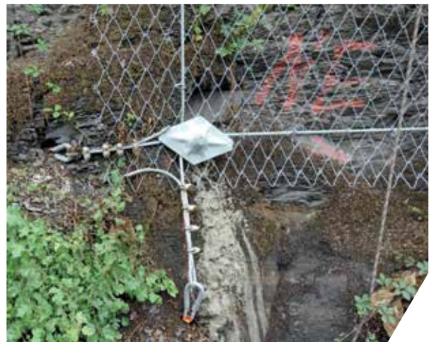
TECCO®-Böschungsstabilisierungen (Randseil-Verankerung)
