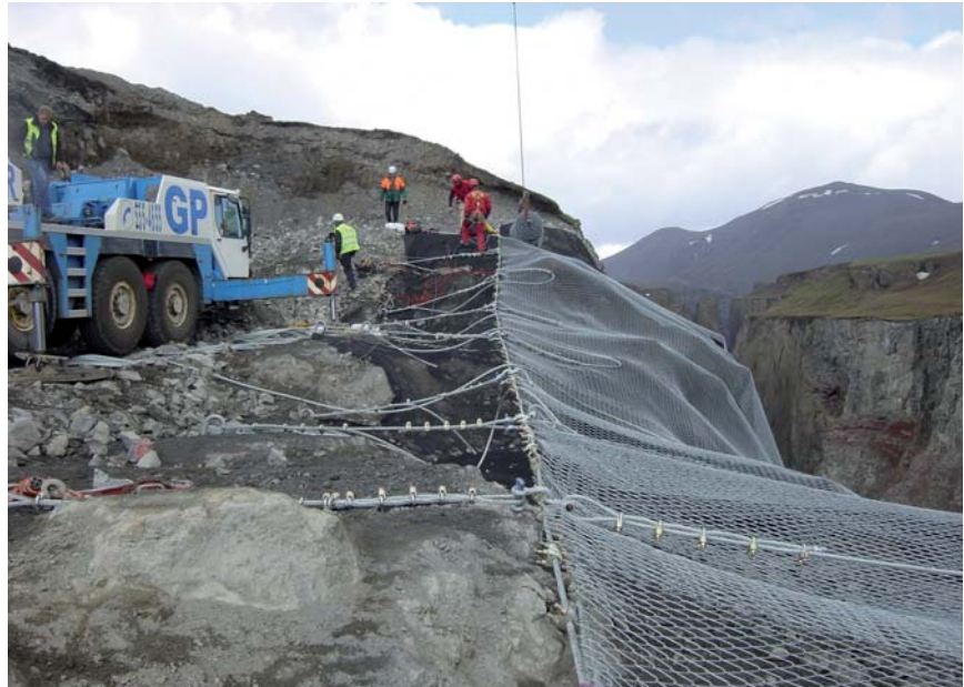
Aufgrund der schlechten Felsgegebenheiten und des steilen Geländes wurden 3 Rollen mittels eines Nähseils verbunden und mit einem grossen Telekran installiert.
