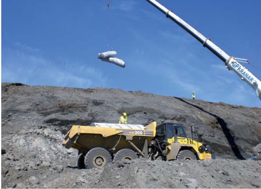
Anlieferung des TECCO® G65/4 Geflechts.
