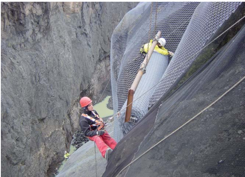
Spezielle Abroll-Vorrichtung zum Anbringen der Geflechtbahnen.
