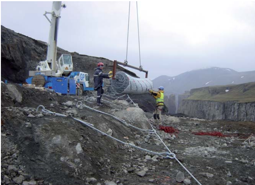
Positionierung der ersten Rolle TECCO® G65/4, Rollenlänge: 50 m.
