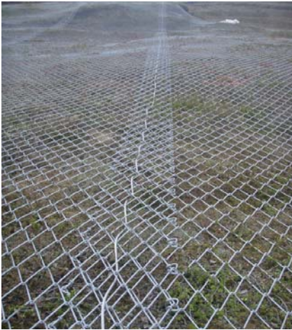
Aufgrund der schlechten Felsgegebenheiten und des steilen Geländes wurden 3 Rollen mittels eines Nähseils verbunden und mit einem grossen Telekran installiert.
