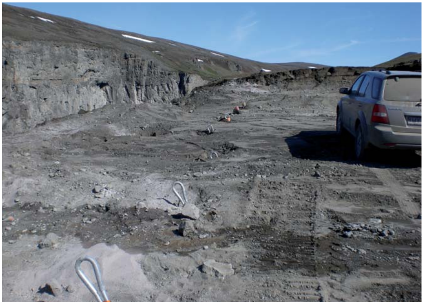
Installation der Seilanker in einer Reihe von je 70 Metern.
