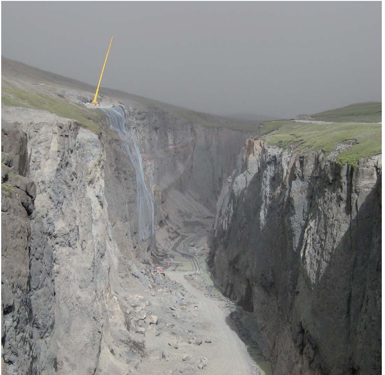
Temporärer Steinschlag-Schutz, Kárahnjúkar Wasserkraftwerk Projekt, Island
