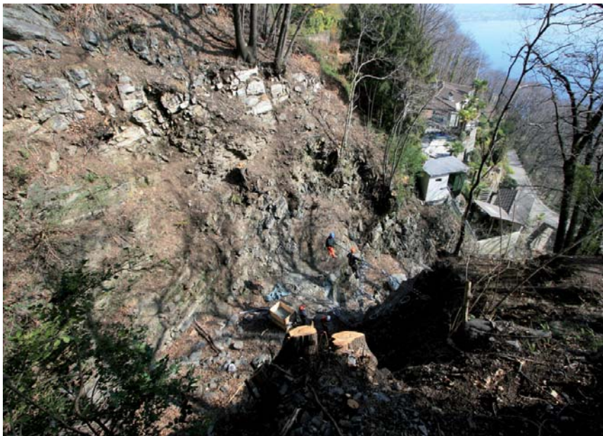
Abb. 2: Blick von oben auf das Gebiet, in dem die Arbeiten durchgeführt wurden.
