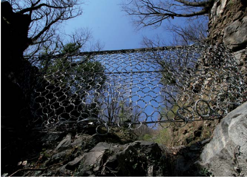
Abb. 6: Barriere Nr. 1 (VX) talseitig von unten gesehen
