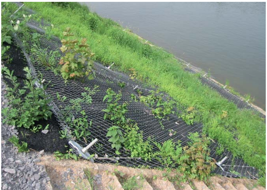
Estabilización del talud con mallas metálicas de alta resistencia TECCO®
