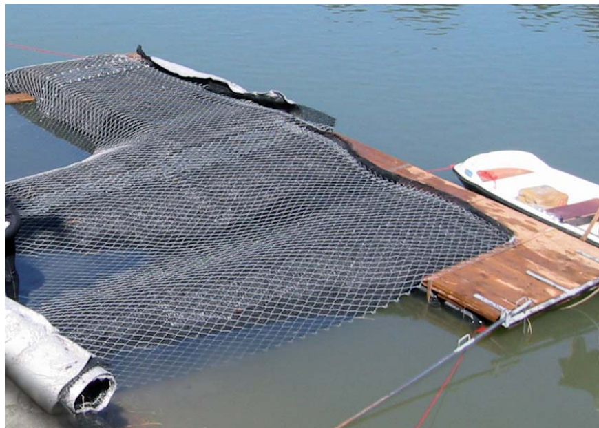
Preparación de la malla metálica TECCO® para su colocación bajo el agua mediante una balsa móvil
